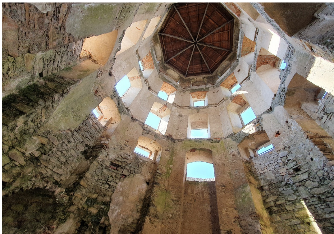
Fot. Nr 13, 14: Ruiny Zamku „Krzyżtopór”, Ujazd ; kolonie mikroorganizmów obszar zabytkowych tynków i wątków kamiennych.
